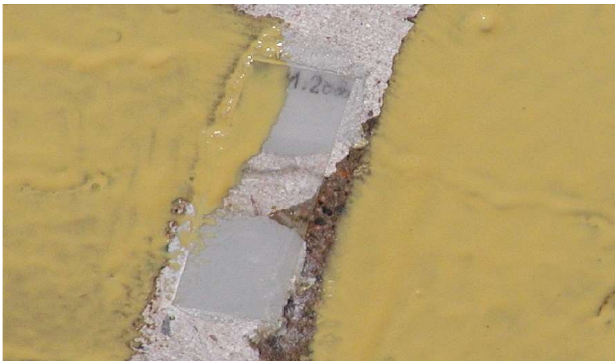
Obr. P-5: Destička ponechaná na pohledu prefa klenby po sanaci betonu ochranným nátěrem
